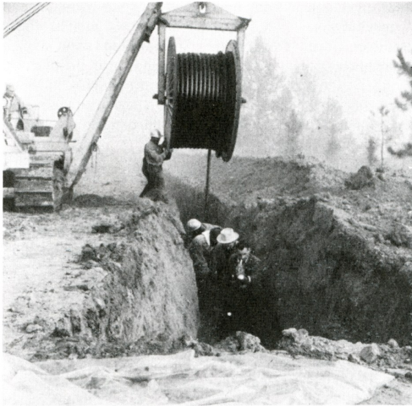
Fig. 6. La transmission sur les liaisons interurbaines est assurée le plus souvent encore par des câbles coaxiaux qui sont enterrés. Ici on pose le câble Boston-Miami. (Cliché ATT.)
