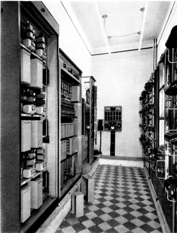
← Installation téléphonique par haute fréquence. Dispatching "Électricité de France" de Marseille.
