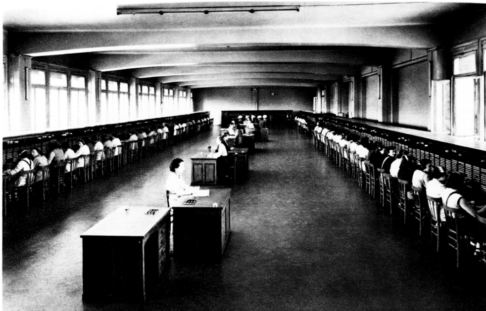
Central téléphonique automatique du réseau public de la ville de Rouen. Salle de l'interurbain. (112 positions d'opératrices.)
