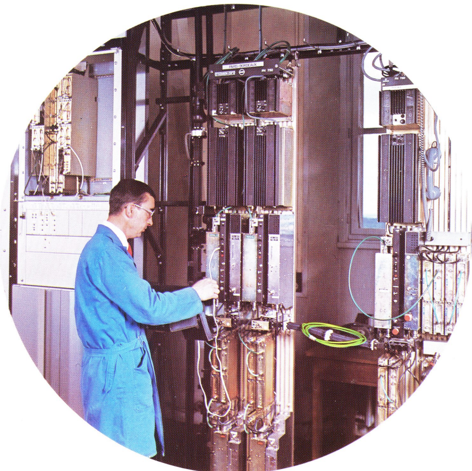
Plus récent, plus compact, de plus grande capacité : FH 750, 2.700 voies par canal.
