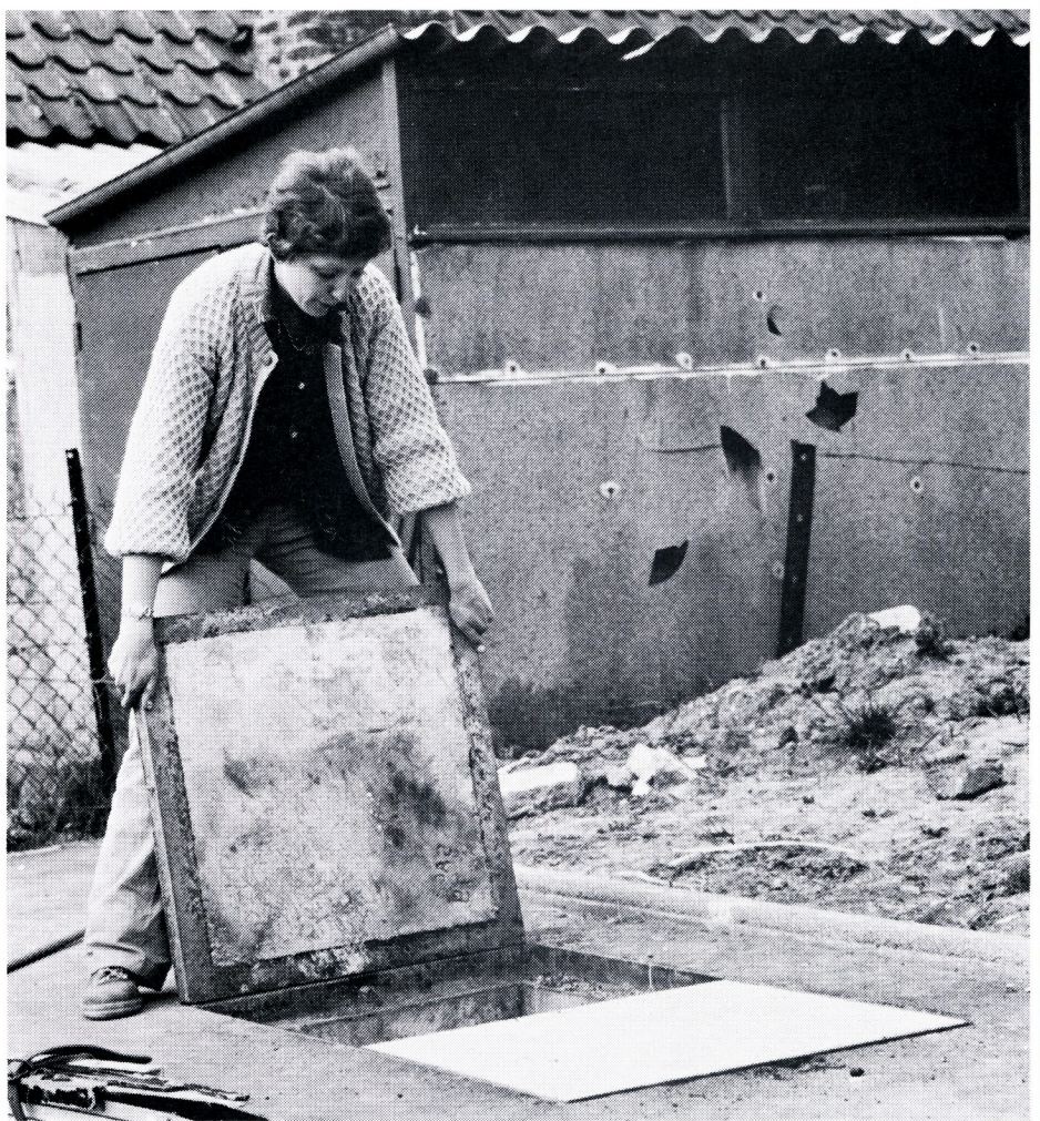
Soulever une plaque de chambre de raccordement...
