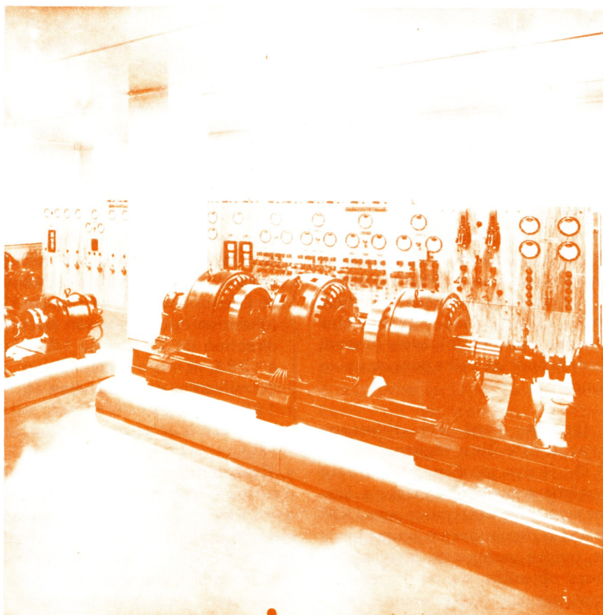
Ci-dessus, aspect d'une station d'énergie d'avant 1939 ; appareillage en cuivre, façade en marbre. Débit possible 2000 A.
