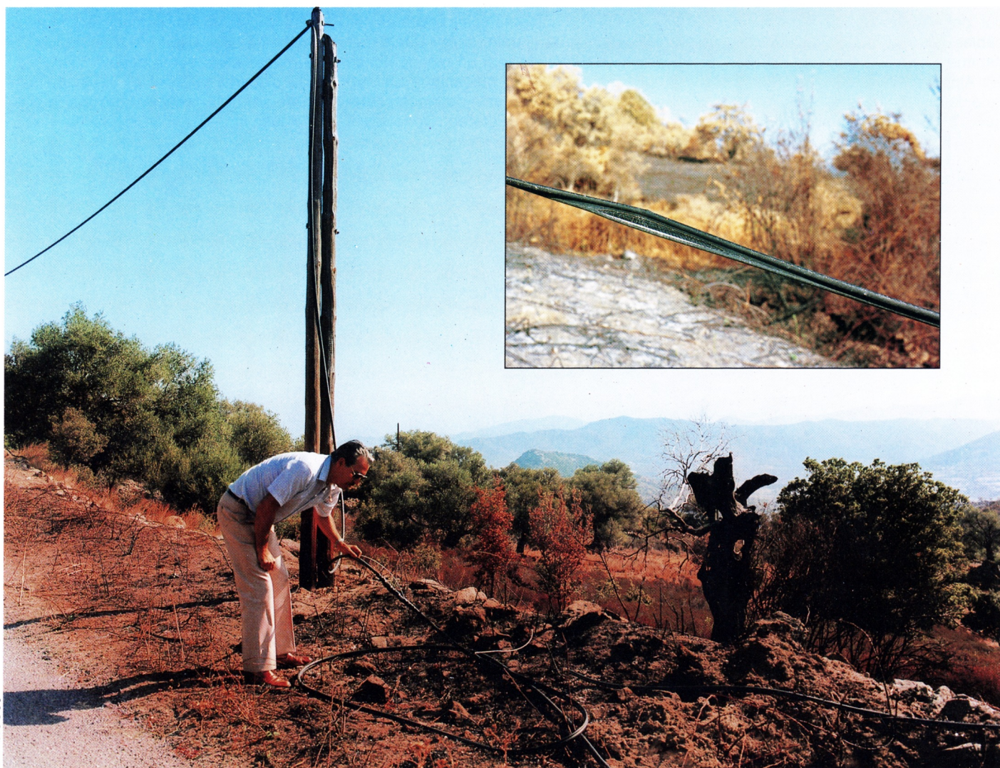
Lors des incendies, les poteaux brûlent jusqu'à un mètre de profondeur. En médaillon : la gaine des câbles fond sous l'effet de la chaleur.
